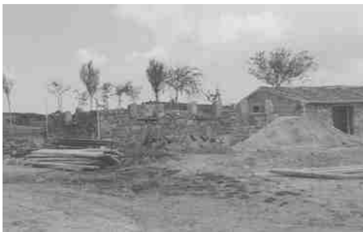
Construcción de casita y servicios, 1991
