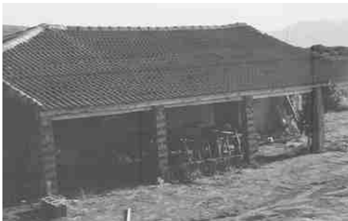
Construcción de la terraza, 1986
