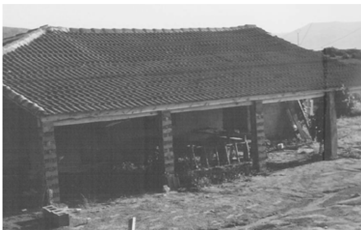
Construcción de la terraza, 1986
